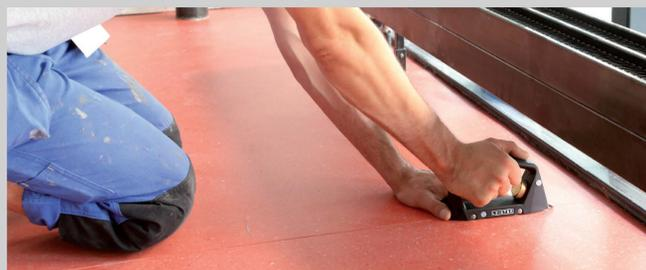
Позволяет качественно дорезать шов до стены
