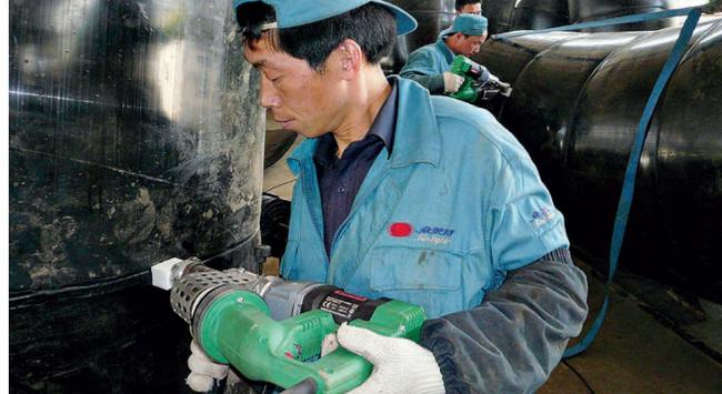
Экструдер FUSION 2 при сварке резервуара
